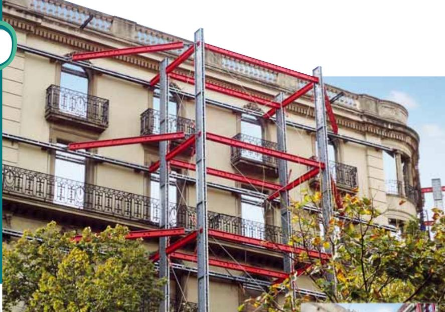
**1** Un esempio di ristrutturazione non conservativa: si evidenzia il mantenimento di un involucro edilizio interamente svuotato di tutto il suo contenuto; all'interno verrà realizzato un edificio completamente nuovo che avrà solo l'apparenza di un edificio storico
