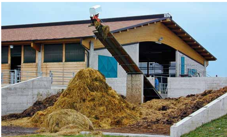
L'allevamento dei bovini su lettiera è sempre meno diffuso – specialmente nei grandi allevamenti professionali – anche per gli elevati costi di gestione delle deiezioni animali. Nella foto: concimaia a platea all'esterno di una stalla di tipo tradizionale
