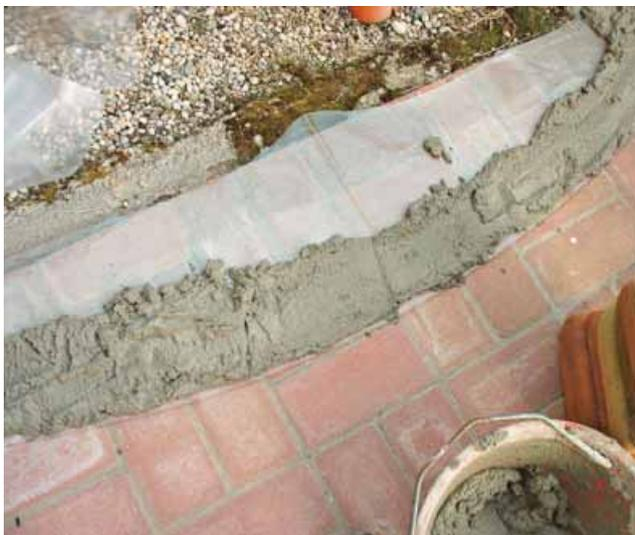
**5** Posa dello strato di malta a "fondazione" del muretto da realizzare
