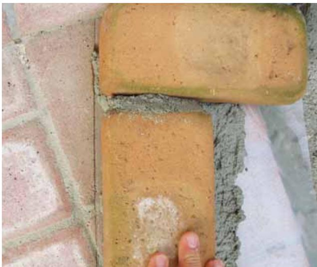
**7** Dettaglio del mattone di "testa" posato perpendicolare rispetto alla lunghezza del muretto
