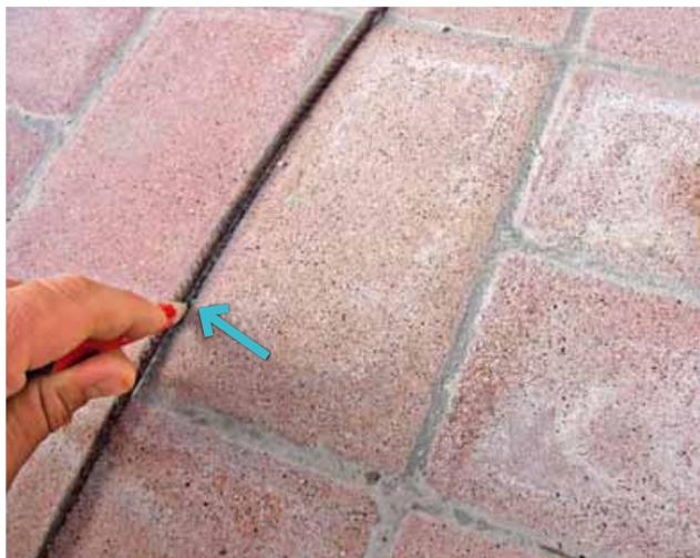
**2** Tracciamento del percorso della muratura con una matita. In questo caso, per dare una forma leggermente arcuata, viene realizzato aiutandosi con un tondino di ferro. Può essere pure valido l'utilizzo di un'asse di legno o qualsiasi altro sistema vi permetta di ottenere la forma desiderata
