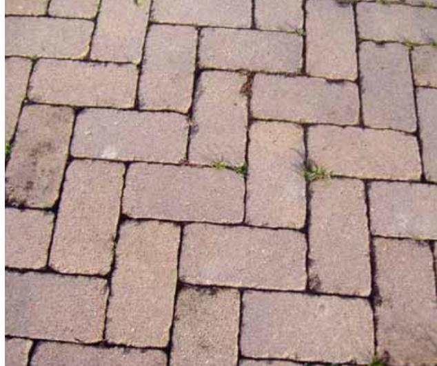
2 Particolare di erbe che crescono tra le fughe di sabbia di una pavimentazione in massello. Una volta eliminate le erbe, si reintegrano le fughe con sabbia
