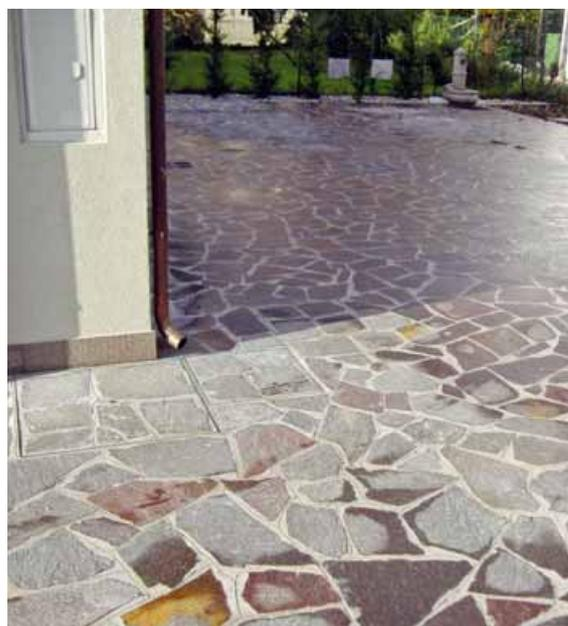
lastre o piastrelle tranciate (regolari o irregolari) posate su un letto di malta di cemento e stuccate con boiaccia di cemento. In alcuni casi, specialmente per le forme a cubetto, la posa viene eseguita su sabbia o sabbia e cemento miscelati a secco e la sigillatura avviene con sabbia o boiaccia di cemento.
