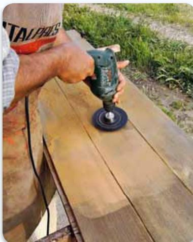
**4** Nel caso di superfici particolarmente danneggiate può essere necessario levigare il legno, prima grossolanamente con un disco abrasivo su platello applicato al trapano...
