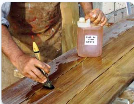
**6** Una volta riportata la superficie del legno alle condizioni originarie, si procede con l'applicazione a pennello d'impregnanti a base d'olio di lino
