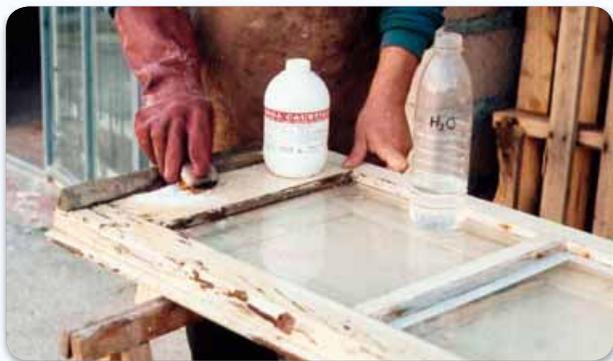
**5** Se lo smalto è molto danneggiato e la vernice è molto vecchia, rimuovete completamente la vecchia vernice con **soda caustica e acqua tiepida** o con uno sverniciatore a base di potassa proteggendo le mani con **guanti**: questi prodotti in polvere vanno mescolati con acqua fino a formare una pasta morbida, che va stesa con un pennello o una **spazzola**. La soda o la potassa a contatto con l'acqua sviluppano calore che fa sollevare sotto forma di bolle o sfogliature lo strato di vernice
