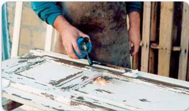
**3** Se lo smalto è molto danneggiato e la vernice è recente, rimuovetela completamente con **fiamma** o con **pistola ad aria calda** con un movimento regolare e continuo facendo attenzione a non restare fermi in un punto
