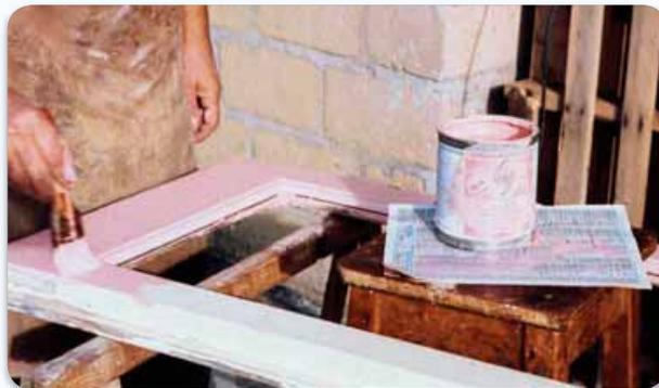
**10** Se il legno risulta molto secco e assorbente, può essere utile (per risparmiare smalto) passare una mano di **olio di fondo**. Segue una prima mano di **smalto naturale a base di olio di lino e pigmento colorato**, diluita al 30% con solvente naturale. Lasciate poi asciugare perfettamente la prima mano, quindi carteggiate con una **carta abrasiva di grana 400**. Finite con una seconda mano di smalto naturale a base di olio di lino e pigmento colorato, diluita al 10% con solvente naturale
