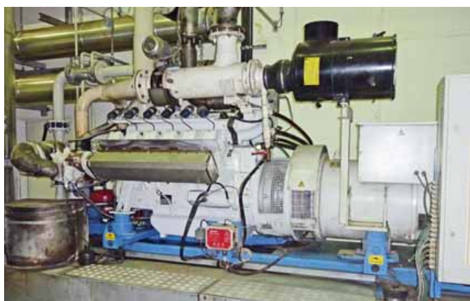
Motore endotermico alimentato a syngas
